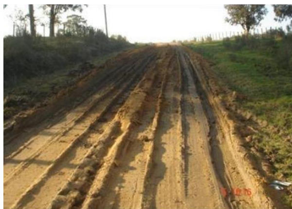
Figura 7. Revestimento de estrada com fração fina predominante (D'Ávila et al. , 2008)
