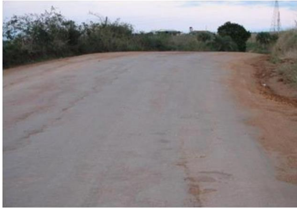
Figura 8. Revestimento de estrada com argila vermelha (D'Ávila et al. , 2008)
