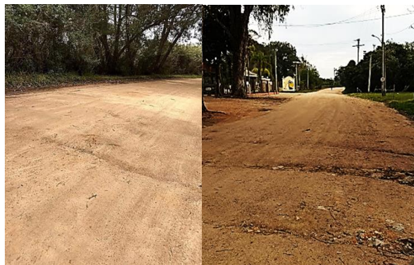
Figura 10. Formação de ravinas observadas na Alameda Mano Serpa (autores, 2018)
