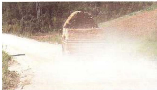
Figura 2. Excesso de pó na pista (BAESSO E GONÇALVES, 2003)
