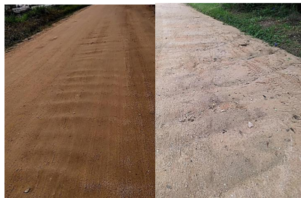
Figura 9. Ondulações longitudinais observadas na Alameda Mano Serpa (autores, 2018)
