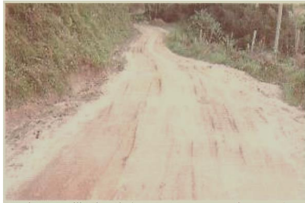
Figura 1. Trilhas de roda (BAESSO E GONÇALVES, 2003)
