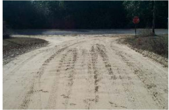
Figura 5. Ondulações longitudinais (PARKER, 2012)
