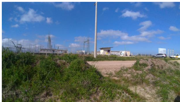
Figura 2. Local onde foram extraídas as amostras do solo. Ao fundo Subestação Marmeleiro da CEEE. Fonte: Autores (2018).
