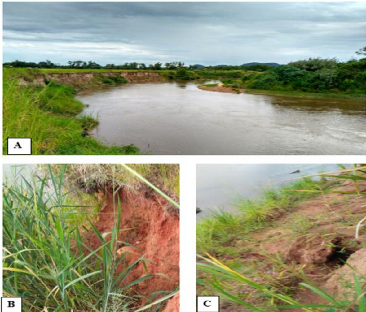
Figura 1 – Exemplos dos taludes fluviais existentes no rio Soturno.
