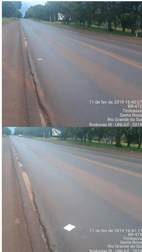
Figura 5. Afundamento Plástico da Trilha na BR 472
