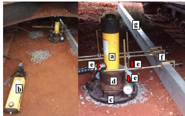
Figura 5. Equipamentos do ensaio de placa
