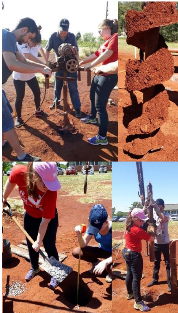
Figura 4. Execução das colunas
