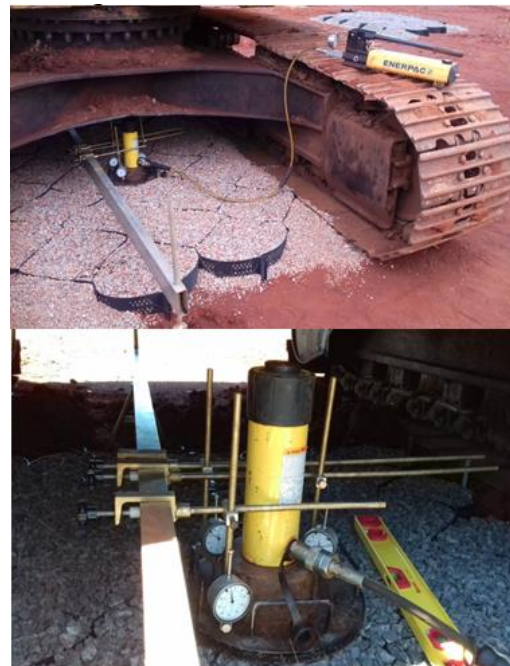
Figura 3. Sistema de reação, transmissão de carga e medição de deslocamentos
