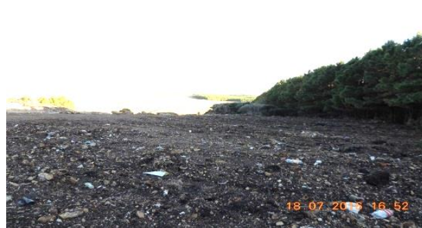
Figura 6. Vista da área após cobertura com solo
