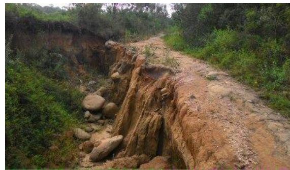
Figura 1: Ocorrência de voçoroca na estrada de acesso à Cascata do Salso, Caçapava do Sul / RS.
